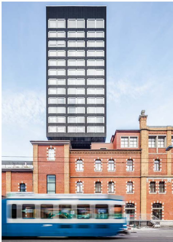
La façade en brique du bâtiment historique du Löwenbräu a servi de source d'inspiration pour la conception des nouvelles constructions sur le site. (Photos: Thies Wachter, Zürich-Berlin)
