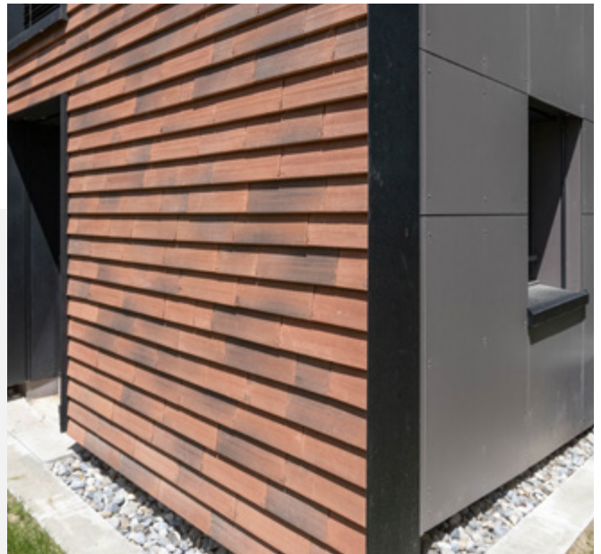
Wie ein Mantel legen sich die Tonziegel über das Dach und die Fassade der sanierten Gebäude der Siedlung Mösliweg in Köniz, BE. (Fotos: Gygax Architekten AG)
