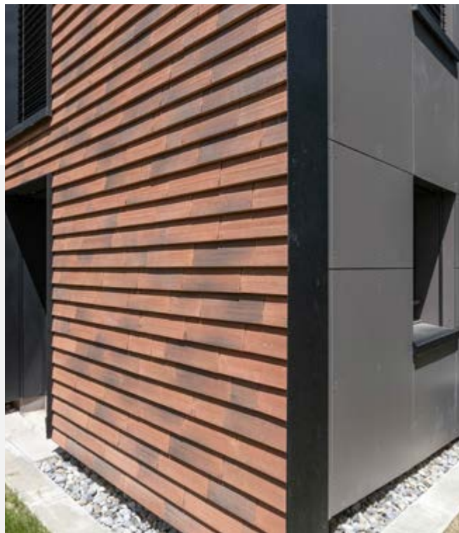
Les tuiles en terre cuite enveloppent toits et façades des bâtiments rénovés de la résidence du Möslweg à Köniz (BE). (Photos: Gygax Architekten AG)
